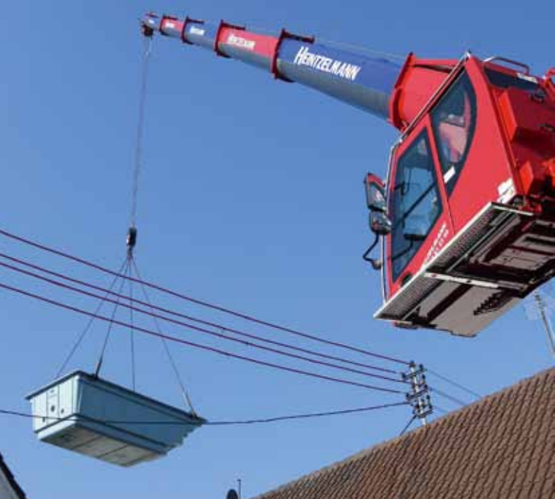
Einheben eines Pools über Freilandleitungen hinweg in einen Innenhof: Auch bei diesem Einsatz machte sich die hochfahrbare Kabine aufgrund der freien Sicht auf das Arbeitsgebiet bezahlt.
